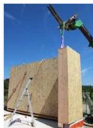
Module trois, la paille est soignée soigneusement dans son coque !
